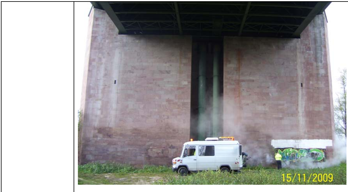
Bild 3/4: Anwendungsbeispiel: Reinigung Naturstein- Brückenbauwerk
