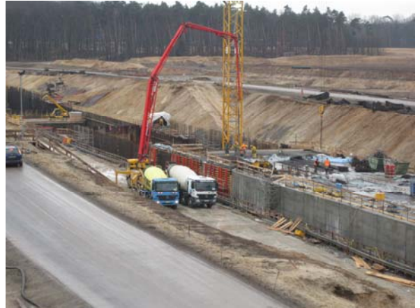
Unterführung der Kreisstraße unter der Landebahn
