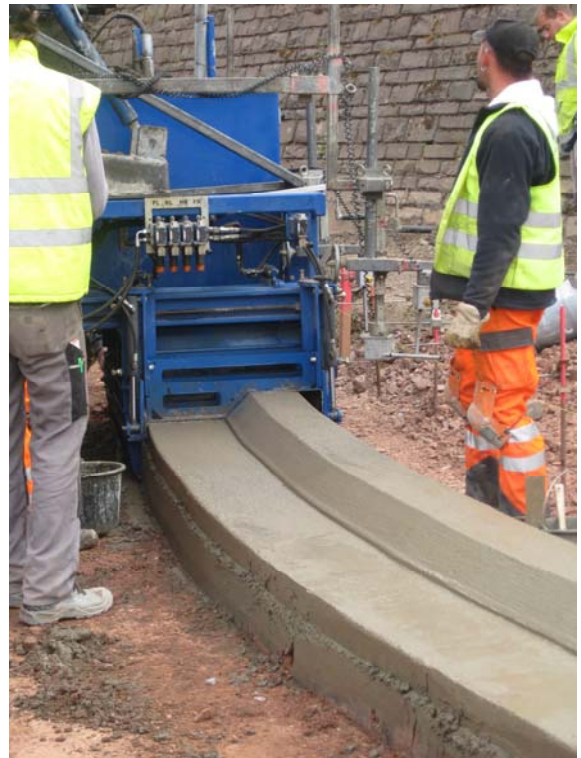
Herstellung Flachbord, Rückenstütze u. Unterbeton →
